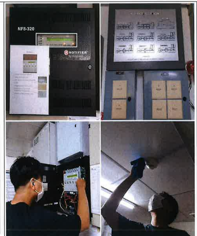
ภาคผนวกที่ 3.20 ตรวจสอบสภาพอุปกรณ์ระบบสัญญาณเตือนอัคคีภัย
