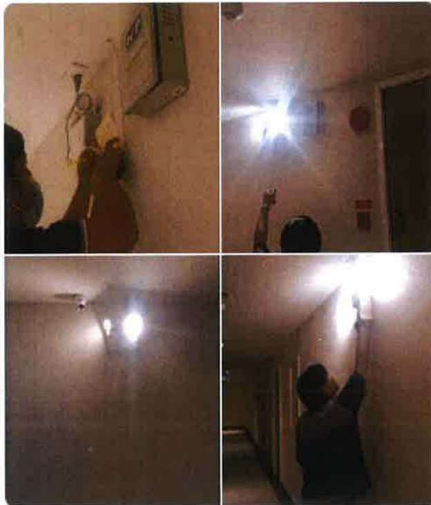
ภาคผนวกที่ 3.21 ตรวจสอบระยะจ่ายไฟฟ้าสำรอง
