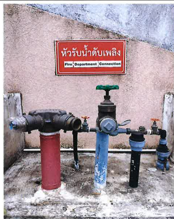
ภาคผนวกที่ 3.51 ตรวจสอบหัวรับน้ำดับเพลิง ด้านหน้าโครงการ
